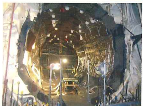
凍土を掘削した状態の接続管施工位置
