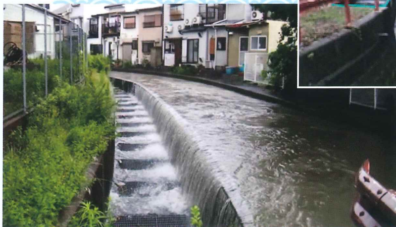
流入施設(寺戸川)(第4向陽小学校付近)
