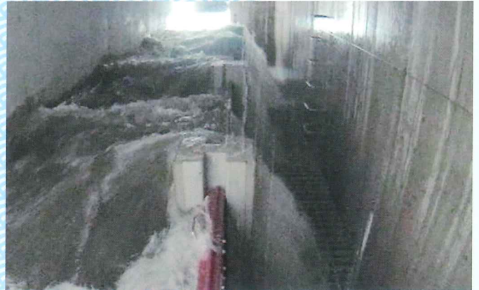
流入施設(五間堀川-5)(国道171号勝竜寺交差点付近)
