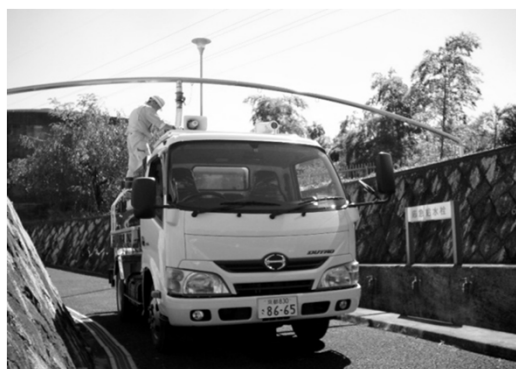
物集女配水池
