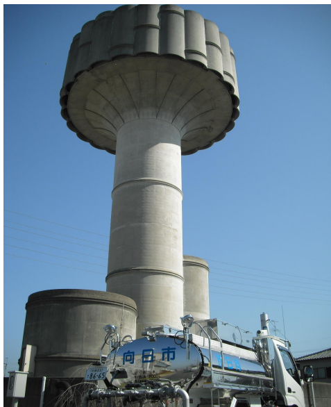
上植野配水塔と給水車
