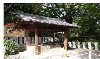
手水舎の修理(R4年度)
