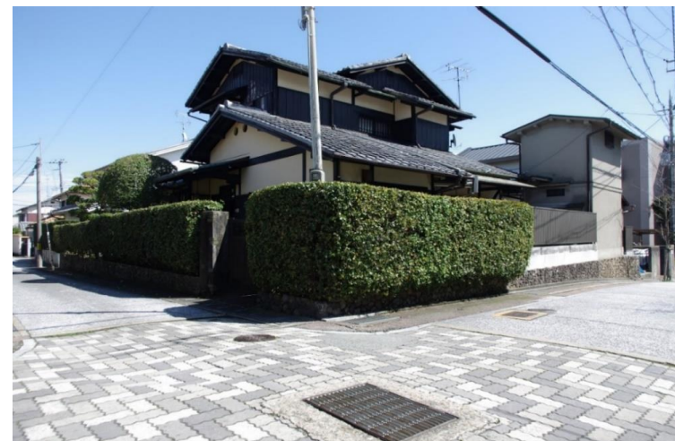
向日庵（旧寿岳家住宅）全景（北西から）
