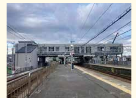
▲上りホームから自由通路を見る
