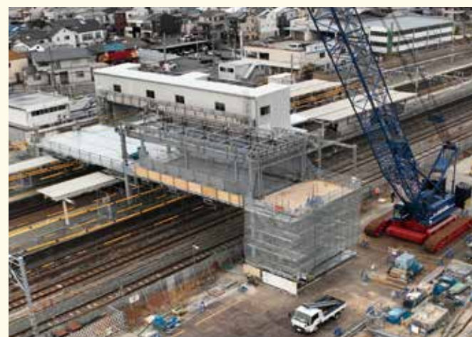
▲鉄骨工事(手前が東口)
