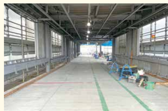
▲外装・屋根工事(西口から東口方面を見る)
