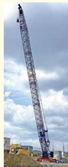
▲クレーンを使って、 杭や鉄骨などを運 んでいます。
