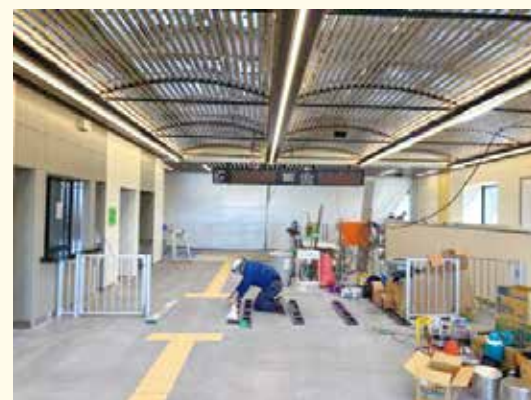
▲内装工事(改札口付近)
