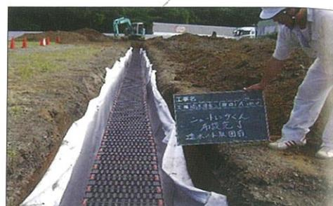
(浸透トレンチ：透水管、プラスチック製品)
