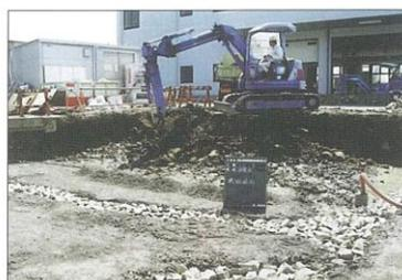
(空隙貯留浸透施設)
