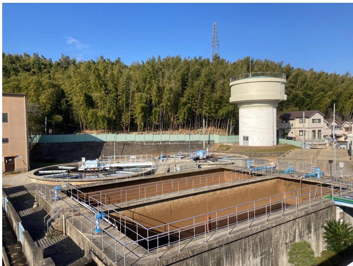
物集女西浄水場
