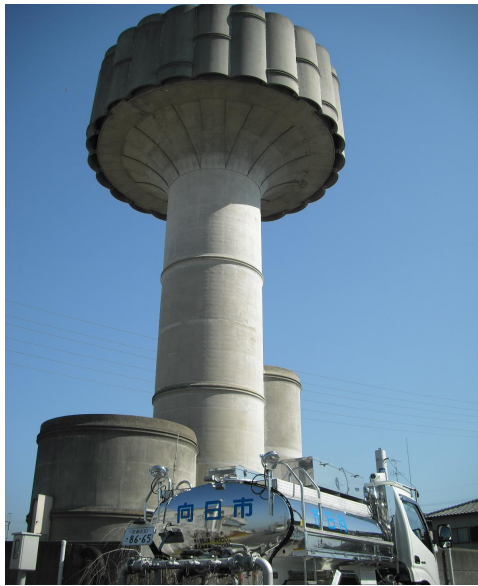
上植野配水塔と給水車
