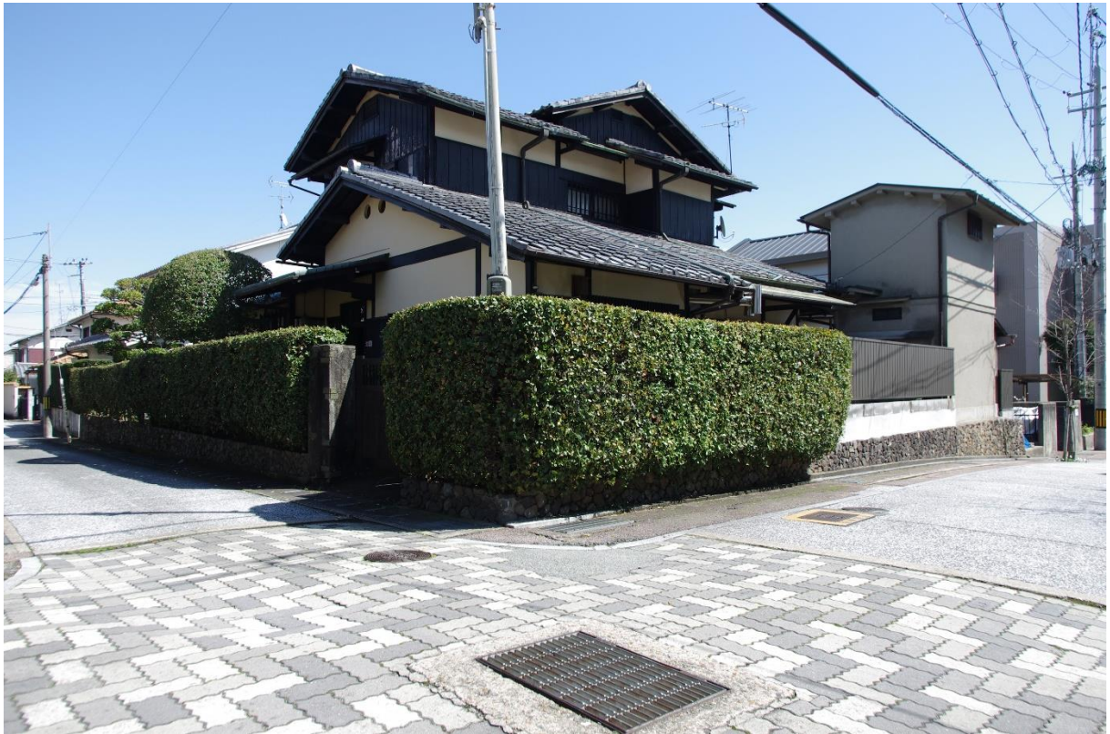
●外観（北西から）
