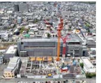
▲J R向日町駅東口整備の様子
