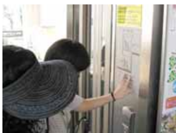
エレベーターの点字案内板
