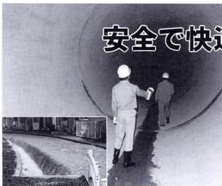
地下15メートルに埋設された雨水幹線。約1万立方メートルの雨水を貯留することができます。(左下)第4向陽小南側に設けられた取水口。寺戸川からあふれた水が流れこみます
