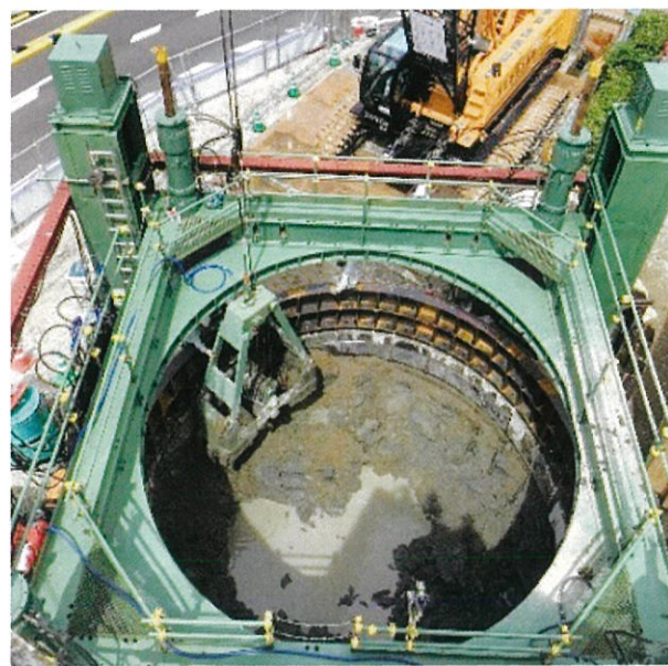
和井川接続施設立坑工事
