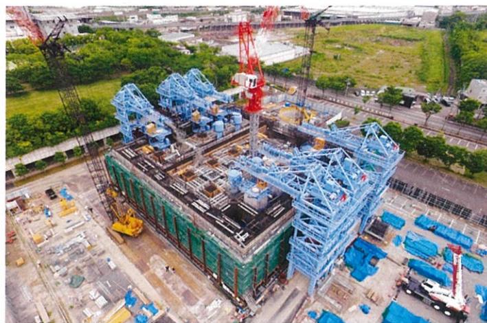
呑龍ポンプ場建設工事
