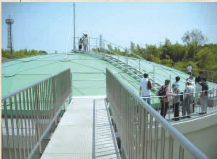
耐震化した第3配水池を見学
