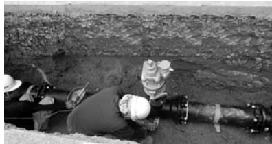
古い水道管を耐震性の水道管に取り替え
