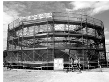
発進立坑築造工事
