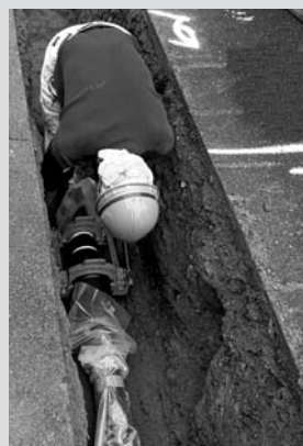
老朽配水管の更新工事
