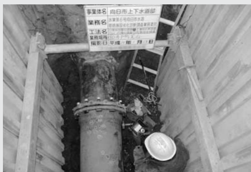
水道管の劣化診断調査
