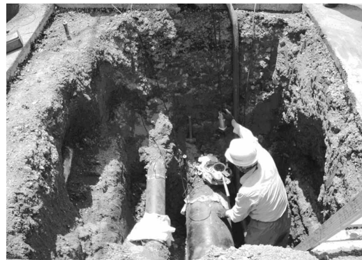
古い水道管の劣化状況の調査
