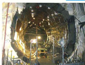
凍土を掘削した状態の接続管施工位置
