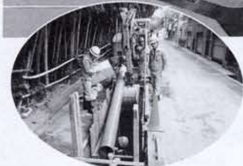
着々と工事が進む公共下水道
